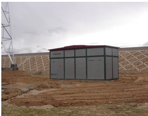
世界屋脊青藏铁路建设工程
