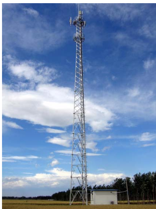
梅泰诺三管通信塔
