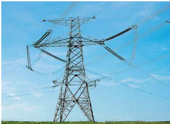
作为架空地线（最上方的2根避雷线）
