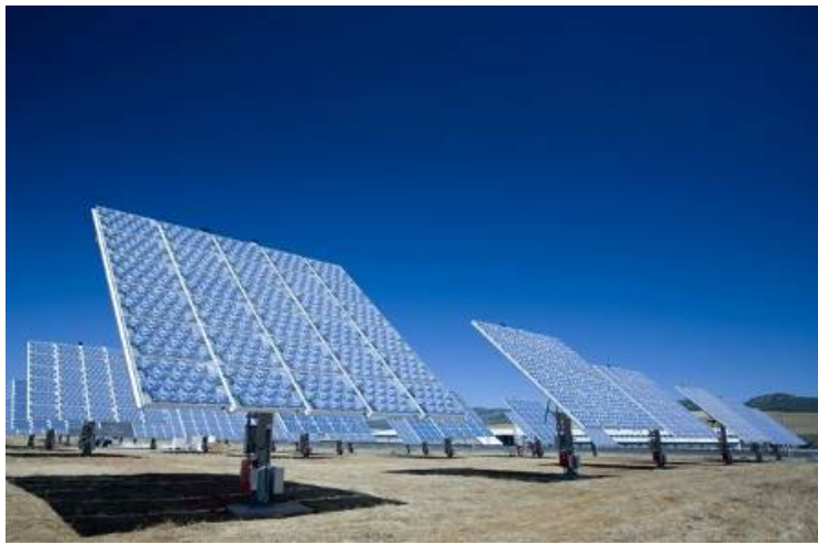
SolFocus公司在西班牙投产建设的一座200KW的CPV示范发电场
