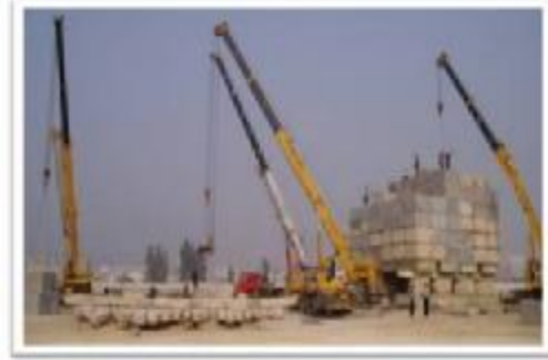
地基基础工程 单桩静载荷试验（堆载系统）
