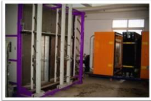
建筑节能工程 围护结构热工性能试验
