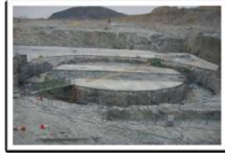
建设中的宁德核电站
