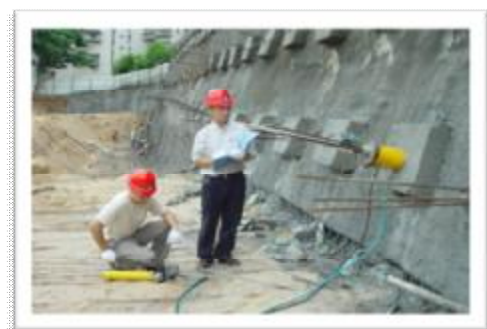
边坡支护工程 锚杆抗拔力试验
