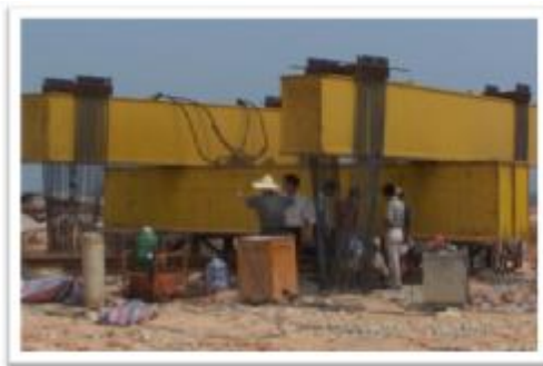
地基基础工程 单桩静载荷试验（锚桩系统）
