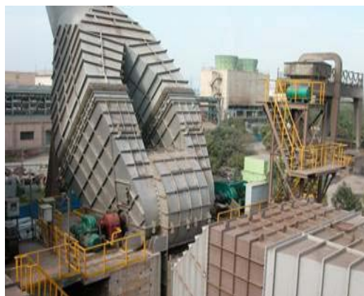
宝钢 300 吨转炉除尘风机
