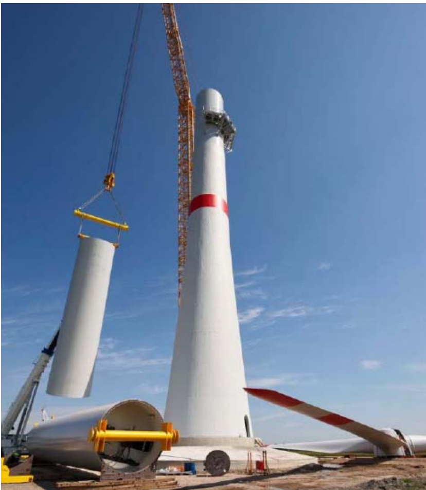
风电塔架安装现场
