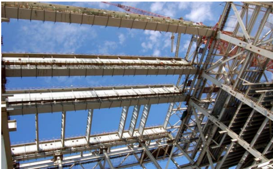
火电锅炉岛钢结构产品安装现场
