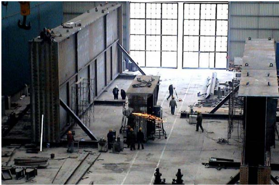
火电锅炉岛钢结构产品
