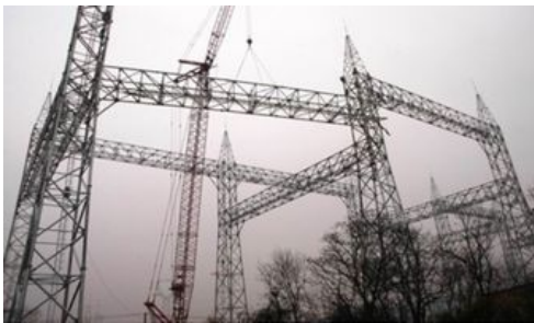
顺德变电构支架
