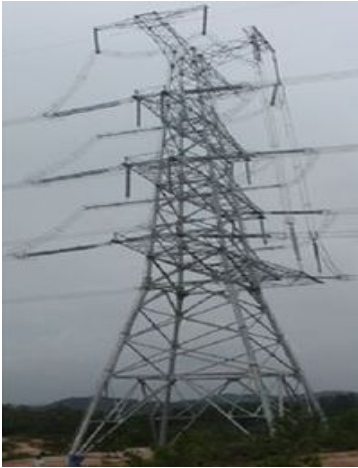
500KV 耐张换位钢管组合塔
