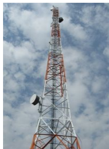
75 米高通讯角钢铁塔
