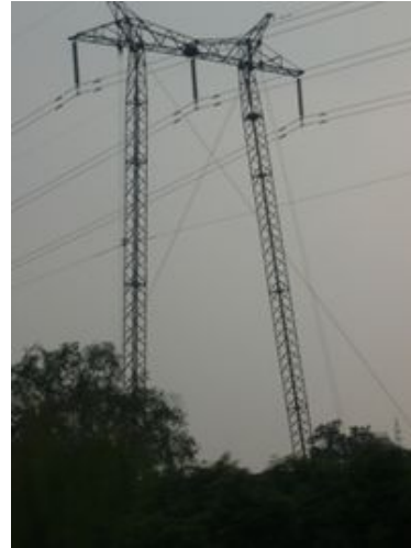
500KV 门型直线角钢塔
