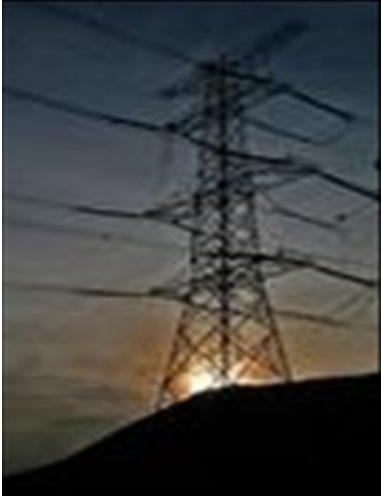
750KV 双回路直线角钢塔
