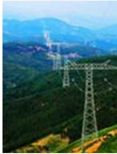
800KV 向上线直线角钢塔
