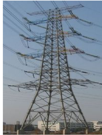
500KV 同塔四回钢管组合转角塔
