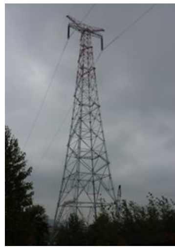
±800KV 向上线大跨越钢管组合塔
