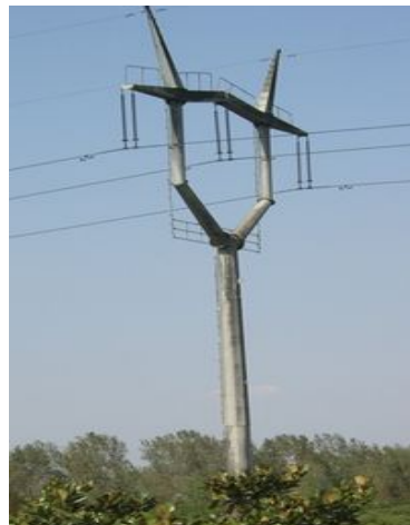
220KV 杯型单柱钢管塔
