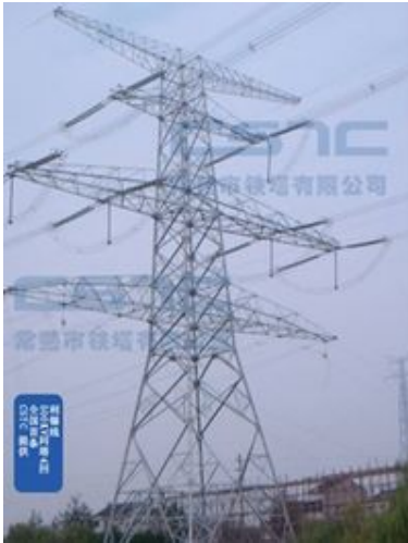
500KV 同塔四回路直线角钢塔
