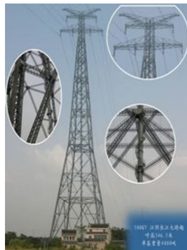
500KV 江阴长江大跨越角钢塔
