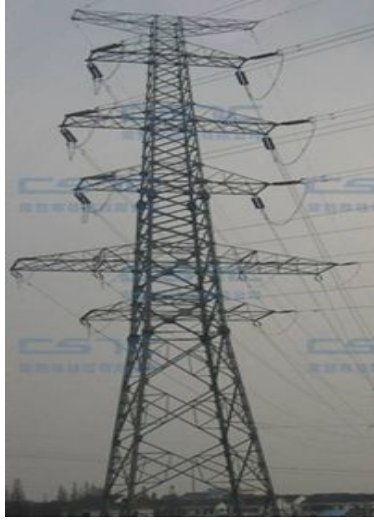
220KV 同塔四回路转角角钢塔
