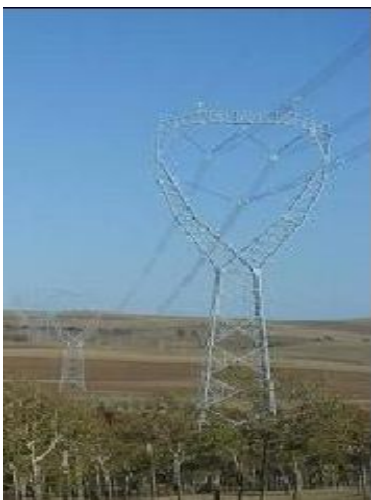
500KV 猫型直线塔
