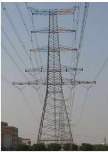
500KV 同塔四回钢管组合直线塔
