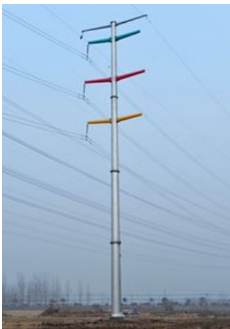
220KV 复合材料绝缘杆塔
