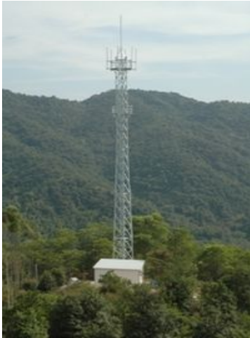
40 米高三管通讯塔
