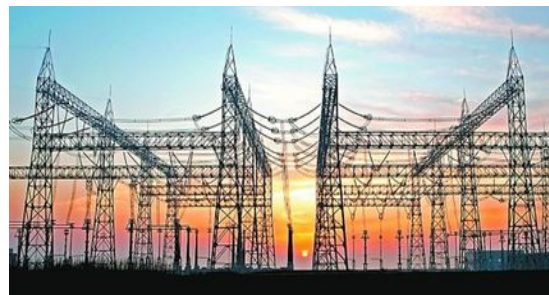
1000KV 晋东南变电构支架
