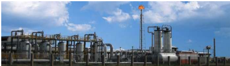
图：分子筛脱水装置（为哈萨克斯坦某油田提供的成套系统装备）
