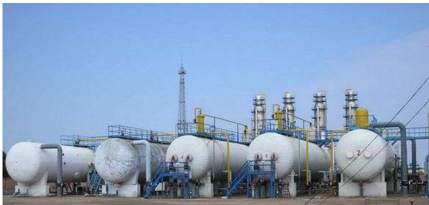
图：高效分离器（为中石化胜利油田提供的成套装备）
