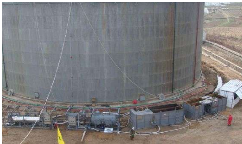
图：某储油罐清洗作业现场
