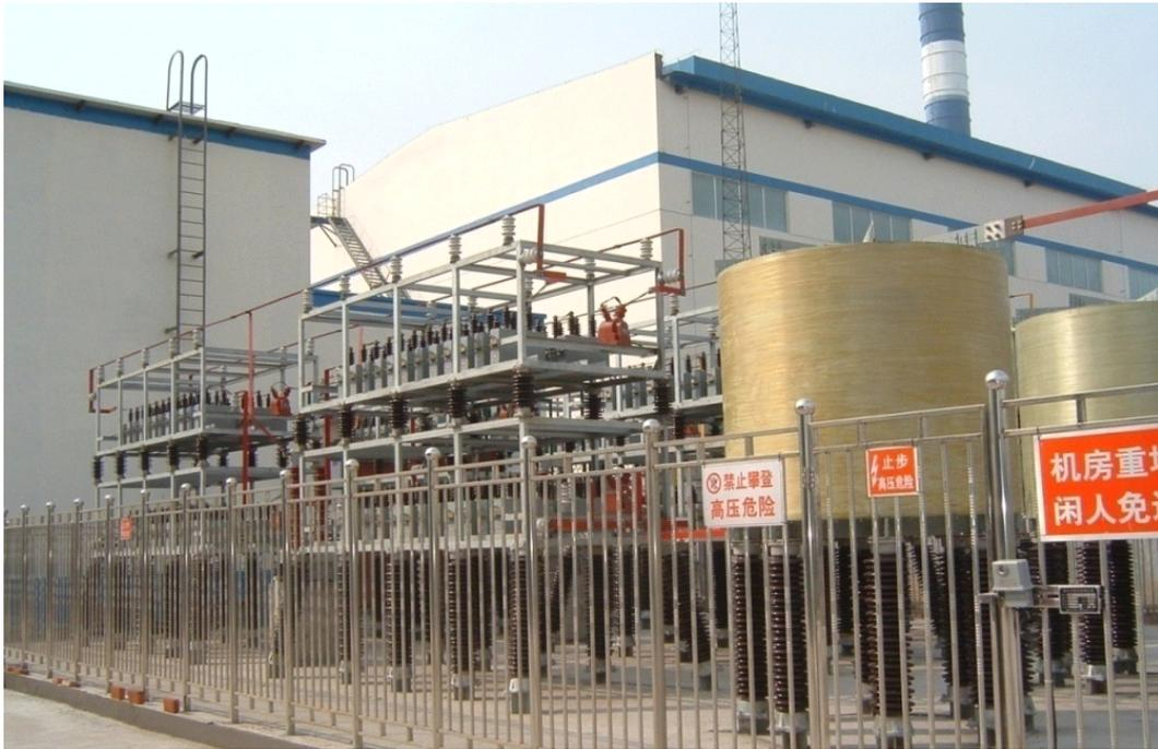
运行于泰安泰山铝电有限公司大封电解铝厂的 TBB110-33000-AQ 110kV 高压并联无功补偿装置
