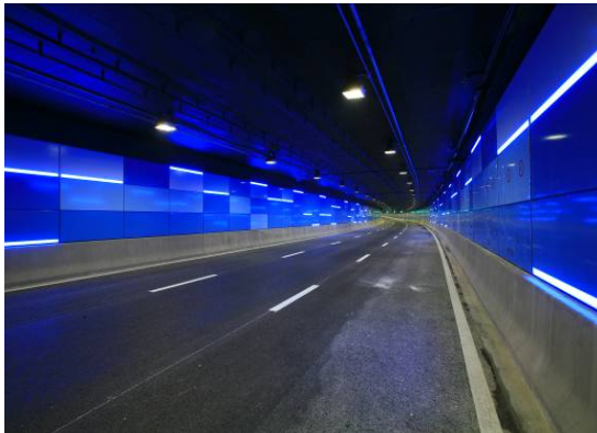
上海外滩隧道
