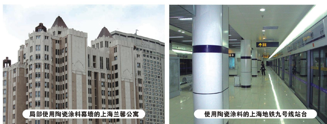
图：采用陶瓷涂料涂装的上海兰馨公寓外墙及上海市地铁九号线站台
