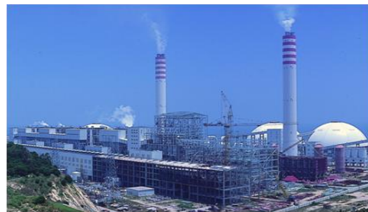
漳州后石电厂（脱硫等设备钢结构）
