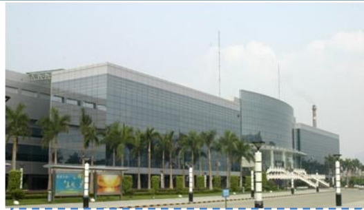
柳州卷烟厂厂房（中国建筑钢结构金奖）
