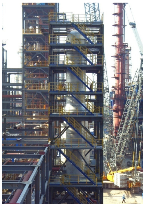
10,500 平方米大型板壳式换热器应用中石油乌鲁木齐石化公司
