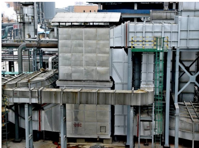
大型板式空气预热器应用于四川泸天化股份有限公司 30 万吨/年合成氨装置
