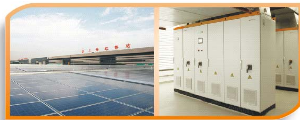
上海虹桥枢纽6.68兆瓦光伏发电项目
