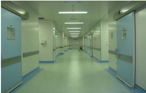
净化生产车间
