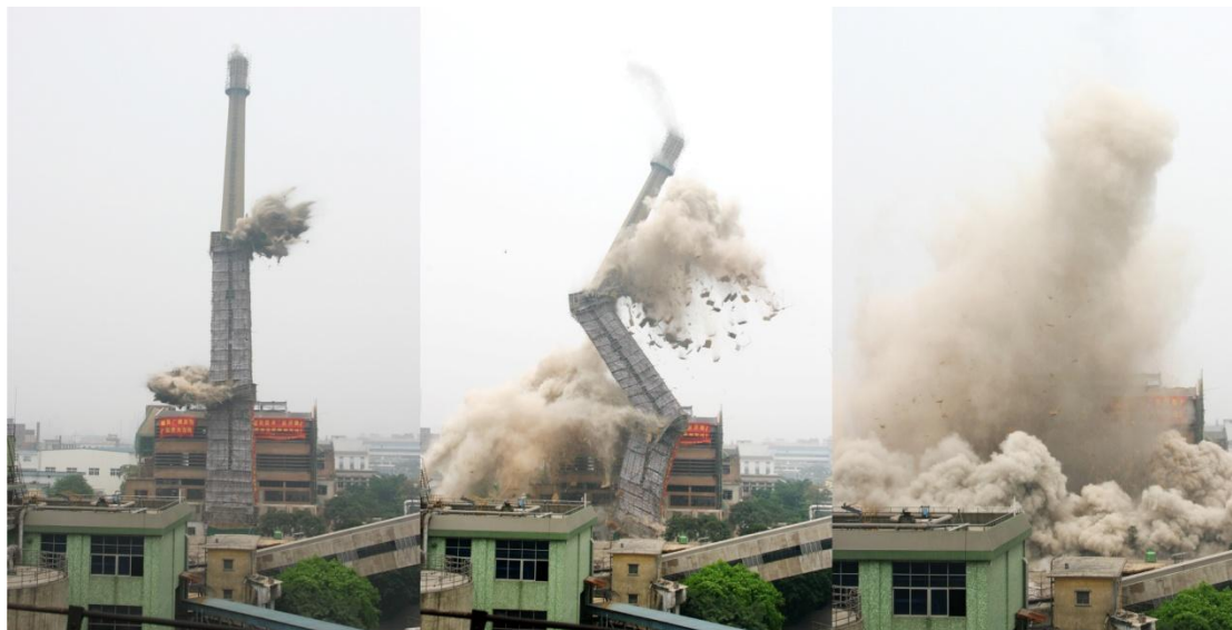
广州造纸厂 100 米烟囱拆除爆破（2005 年）
