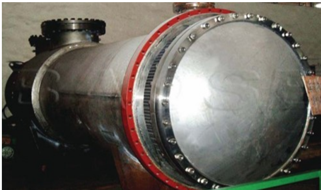
脱氢塔冷凝器
