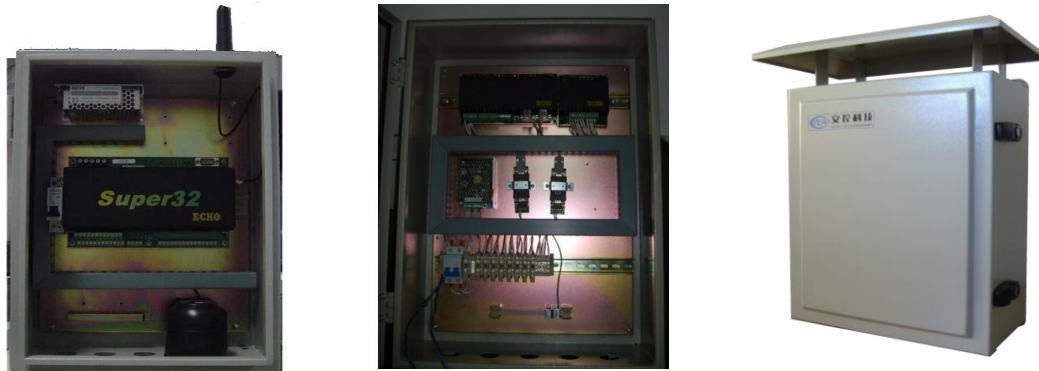
井口数据采集器（油井） 井口数据采集器（水源井） 井口数据采集器（气井）
