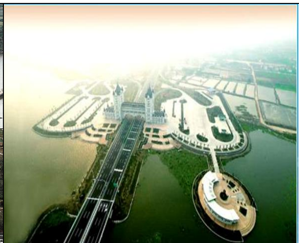
宁常高速公路溇湖服务区
