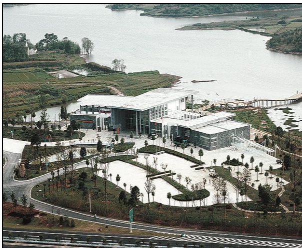
宁杭高速公路东庐山服务区
