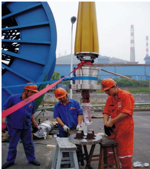
公司的动态脐带缆终端安装现场
