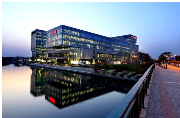
上海博世总部办公大楼
