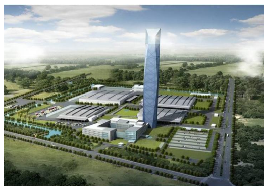
通力电梯测试塔项目
