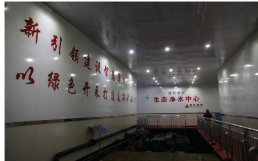
潞安集团漳村煤矿井下水处理项目
