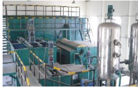
山西长治电厂循环水处理项目
