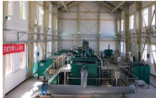
国内首个采用超磁分离技术的市政污水处理工程 —北京市北小河再生水厂二期工程一级强化系统
