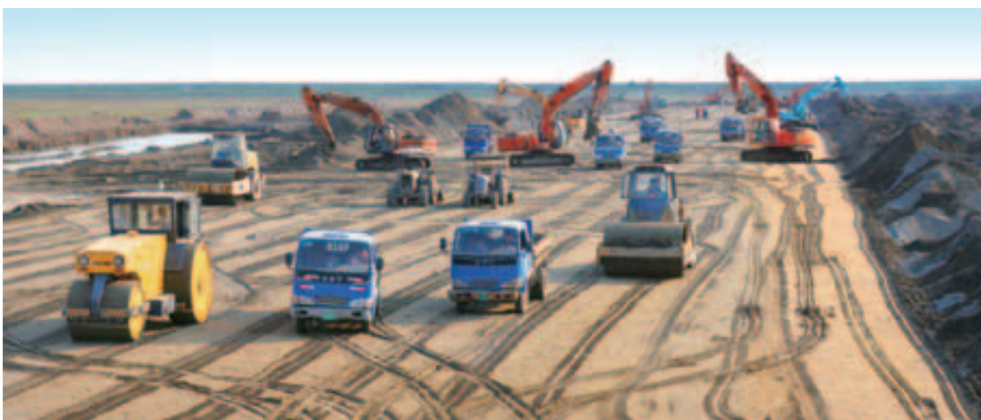
啟東恒大金碧天下道路建設工程實景圖
