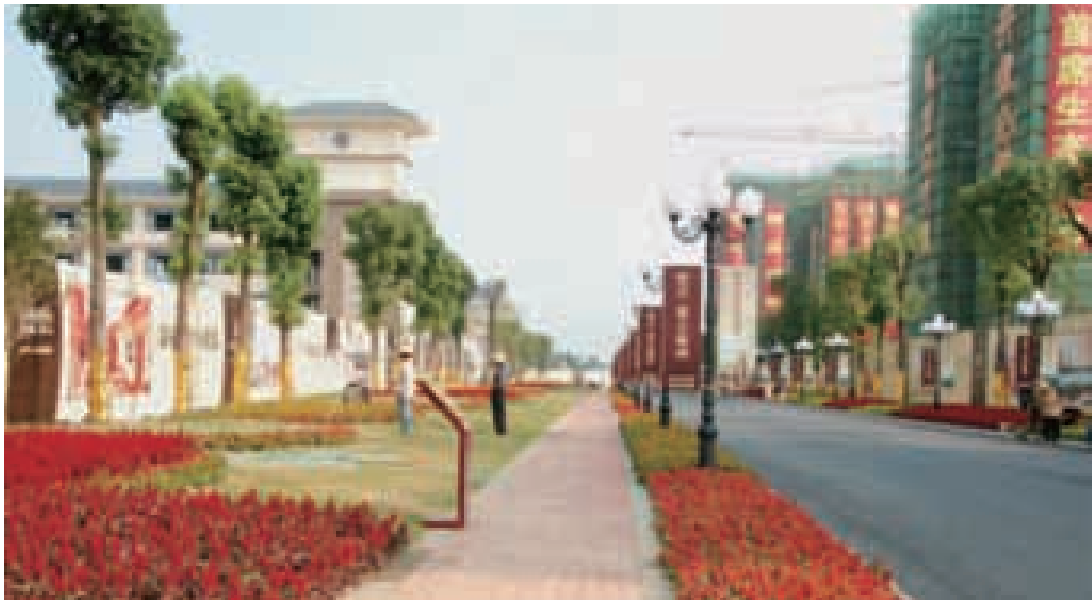
武漢恒大綠洲首期工程現狀實景圖
