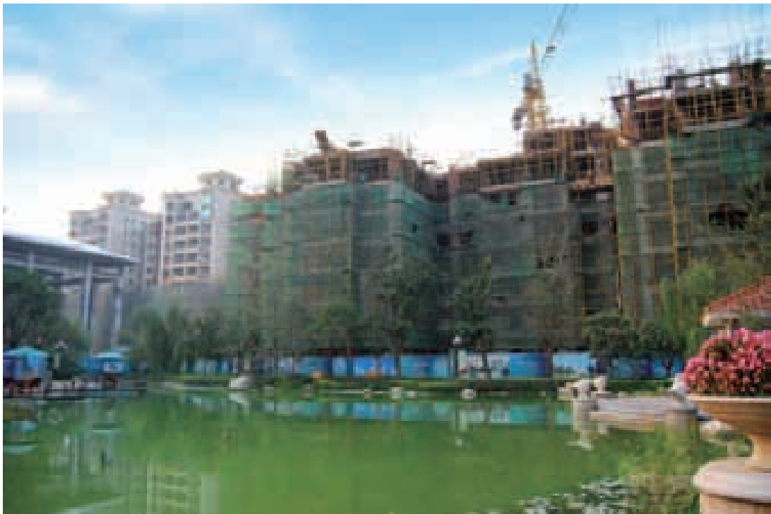
西安恒大綠洲首期工程現狀實況圖
