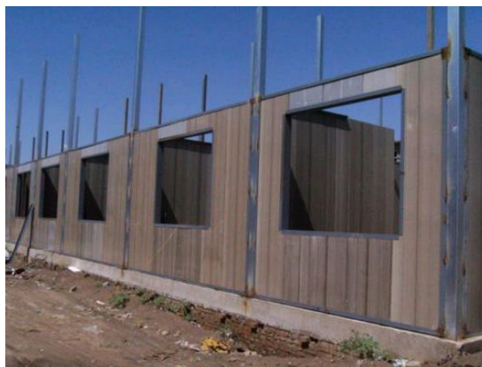
木塑复合墙板应用于外墙
