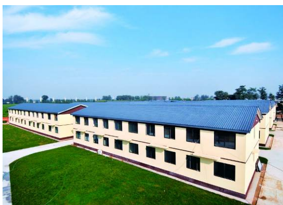
北京房山区长阳镇周转房东区二期
