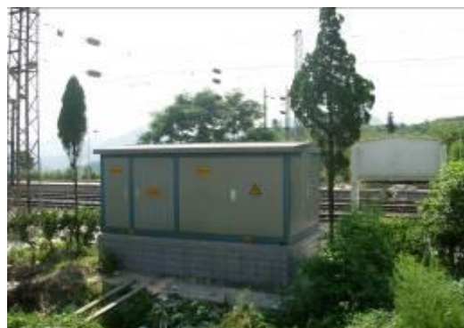
用于铁路的箱式变电站
