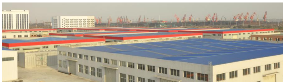
2014 年 11 月木材加工企业建设情况实拍现场图-1
