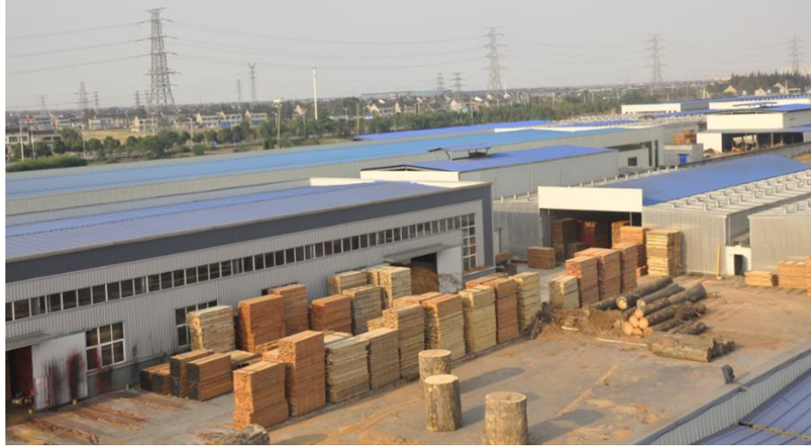
2014年11月木材加工企业建设情况实拍现场图-2
