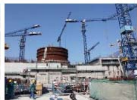
福建宁德核电站
