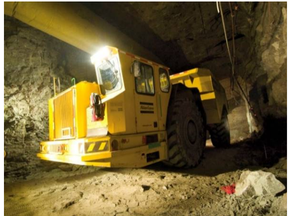
竖井施工装备
