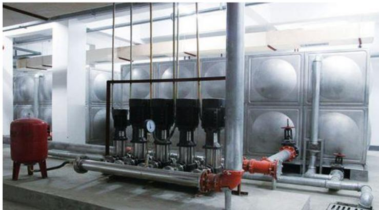
**②区域供水加压泵站：**用于自来水管网前端、中端加压供水。该设备采用了稀土永磁电机水泵、激光颗粒物分析仪、设备前端市政供水管网压力检测保护系统、防水锤组合系统等部件。产品特点为采用设备前端市政管网压力检测保护系统，以及用户终端压力反馈控制模式，保证市政管网及用户管道的压力稳定。防水锤组合系统，有效消除因突然断电，停泵所产生的多种形式水锤对管网和设备的破坏。并且根据用户的实际情况，定制泵组的组合搭配，保证泵站在不同供水时段持续高效运行，节能效果显著。
