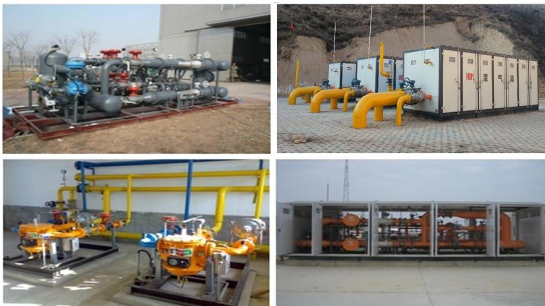
该类设备是将两种或两种以上的气源，通过随动流量式、文丘里引射式（含引射助推式）、高压比例式等技术手段，在保证掺混安全的前提下，按照预先设定的百分比混合成一种新的燃气原料，通过调节燃气的组分和热值达到气源之间互换、调峰、增热减热的目的。我国目前可用的气源种类较多，组分和热值也比
