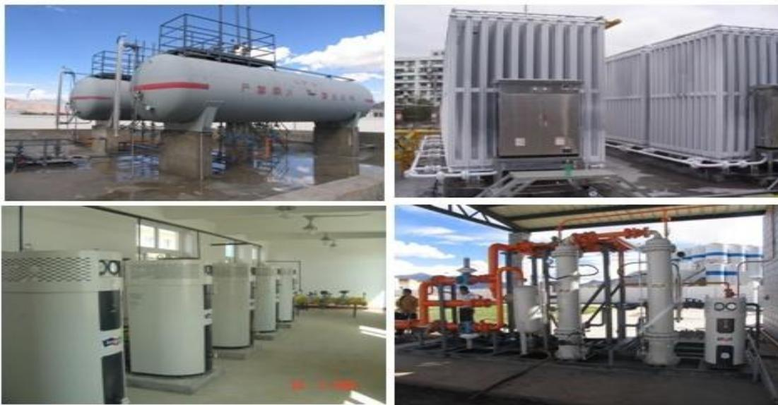
该类产品主要应用于液化石油气的气化、调压及输送，其主要功能是将液态石油气通过热交换气化并过热，使用户端得到洁净且压力稳定的气源。由于液化石油气物理特性很容易从气态还原为液态，因此气化类设备着重考虑气化过程的过热以及与能耗的高度匹配，另外是控制调压、输送过程中的二次冷凝。
