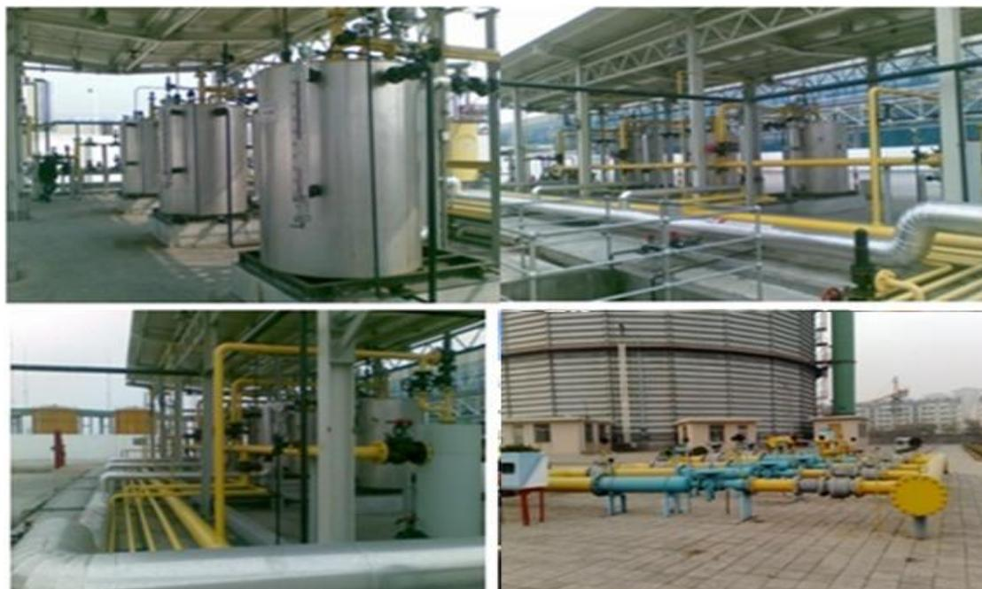
公司的工业其他处理设备将液氨气化利用催化反应脱除工业废气中的氮氧化物，满足环保法规的严格要求。选择性催化还原（SCR）脱硝技术以其脱除效率高，适应当前环保要求而得到电力行业高度重视和广泛的应用。SCR 系统的氨气供应系统一般由氨的储存和供应设备、液氨气化设备、氨/空气混合设备、检测控制系统等组成。
