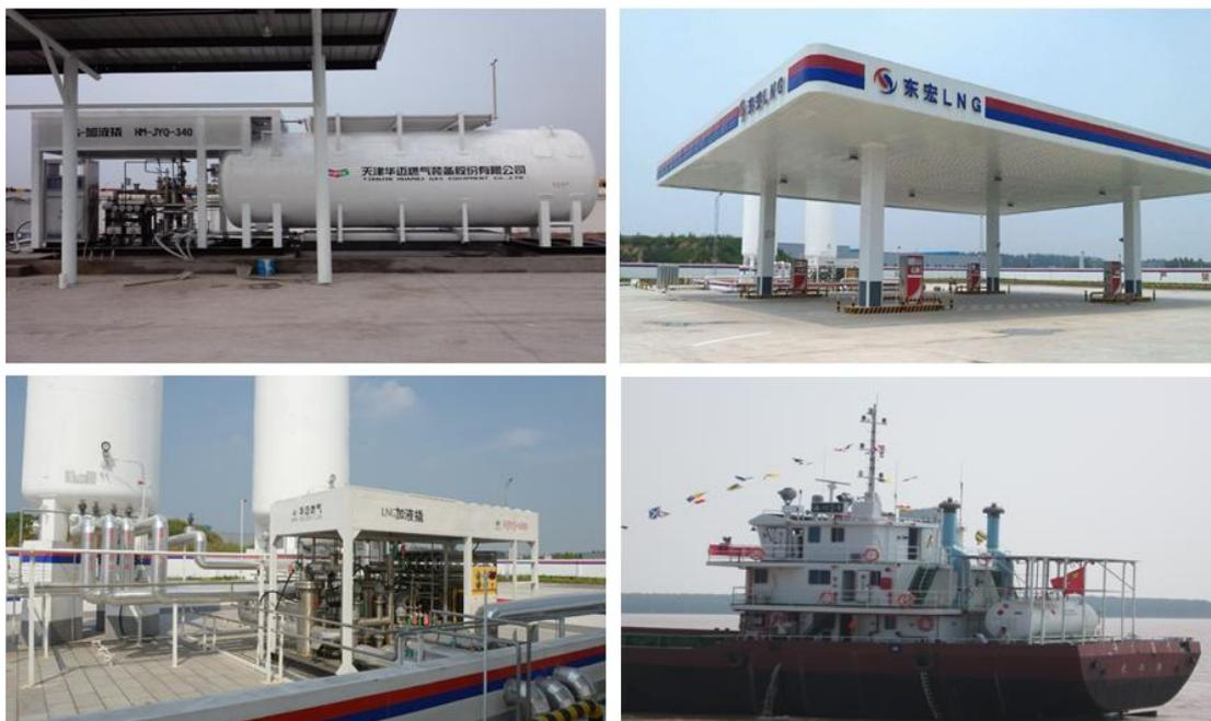
LNG 加注设备是专门为 LNG 汽车或船舶加注 LNG 燃料的专用设备。LNG 加注设备通常包括 LNG 存储部分、泵撬部分、加液机部分、控制部分和其它辅助部分。LNG 加注设备通常要求工艺合理、计量精度高、冷能损失小、控制系统先进可靠。通常有一级站、二级站、三级站等建站模式。随着 LNG 利用的越来越广泛，内河和海上运输船舶和特种船舶也开始尝试使用 LNG 作为燃料。由于 LNG 替代燃油具备很好的经济性和显著的环保效益，因此 LNG 加注设备的市场需求比较旺盛，并且呈现出对技术与工艺性能的多样化。
