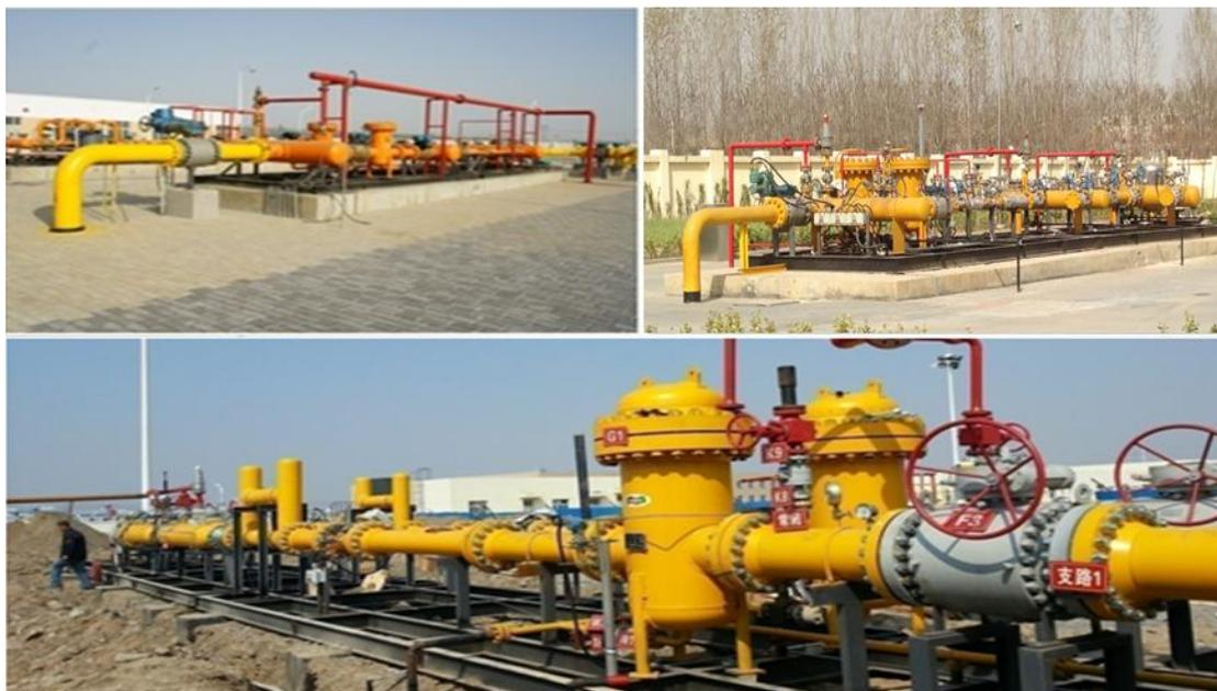
城市门站是长输管线的终点站，是城镇、工业区分配管网的气源站，其任务是接收长输管线输送来的天然气，经过过滤、调压、计量和加臭后送入城镇或工业区管网。站内主要设备有安全阀、汇管、过滤器、调压器、温度计、压力表、流量计、电动阀、加臭装置、换热器及清管球接收装置等。
