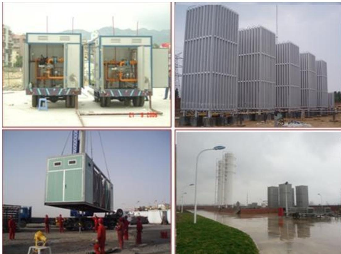
LNG 气化设备主要功能为将输入端液态天然气气化输出为可直接使用天然气。主要满足管网覆盖范围外或者使用管网天然气不经济的工业用户、乡镇集中供气对点供天然气设备的需求，此外还有小部分用于城市调峰备用气源。对于点供用户来讲，选择 CNG 调压设备还是 LNG 气化设备主要考虑的因素为：1、气源供给状况，包括与可稳定获得的气源是 CNG 还是 LNG 以及与气源的距离远近；2、用气规模，由于 LNG 是天然气冷冻到 $-162^{\circ}\text{C}$ 变为等压液体，体积减少 600 倍，非常有利于储存和运输，但对气化装备材料和技术要求较高，用气规模越大使用 LNG 的经济性越高。
