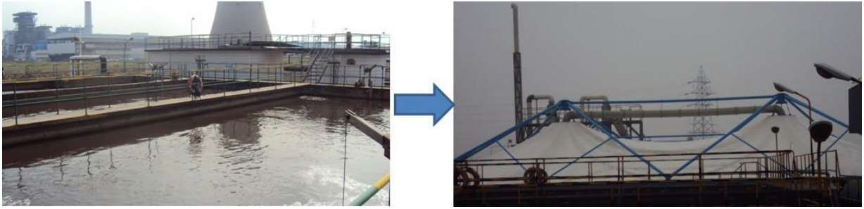
废水处理系统中厌氧池的改造
