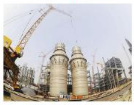
首钢京唐钢铁厂
