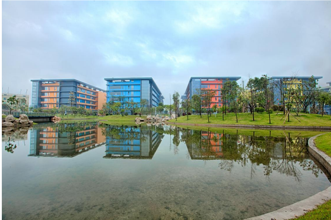
图 3：盘古锦绣数据中心基地 1-4 号互联网数据中心
