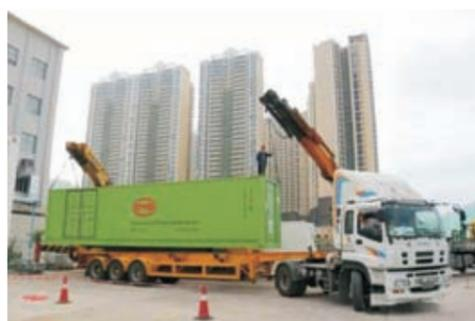
该项目规格为400kW/1.187MWh，项目主要用于为e6纯电动车充电，利用该储能系统进行削峰填谷，减少电动车充电费用支出，为客户创造可观的经济效益。据悉，该系统可同时为12台电动车进行充电。
