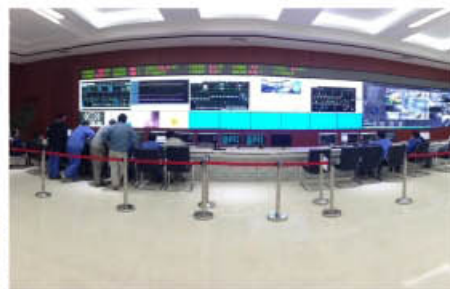
万州电厂主控室内景
