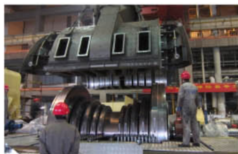
安阳汽缸现场施工
