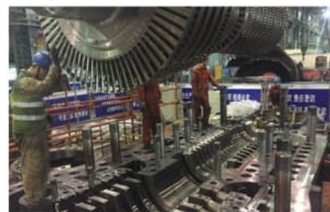
托电转子现场施工
