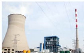
白马电站世界首台600MW超临界循环流化床锅炉
