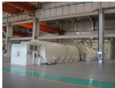
江苏华电戚墅堰二期厂房内景
