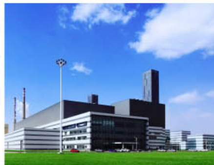
华能F级燃气-蒸汽联合循环电厂
