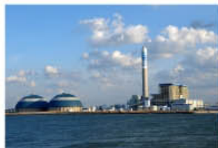
莱州电厂1000MW超超临界机组
