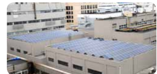
分布式光伏发电项目
