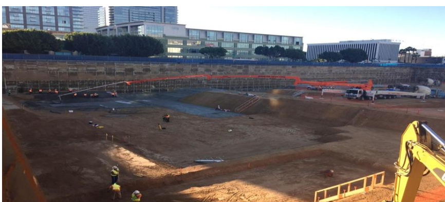
洛杉矶泛海广场施工现场
