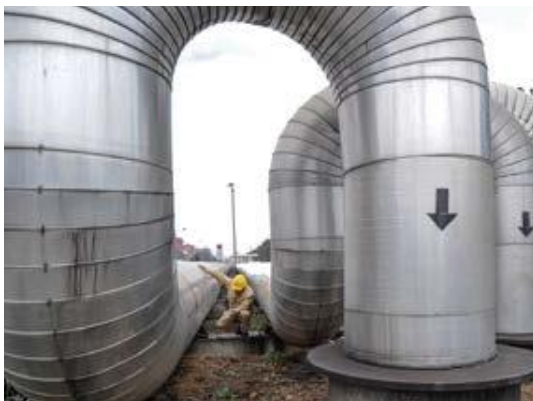
各供热单位强化热力管网巡查
