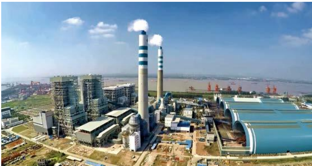
国电泰州发电有限公司二期工程
