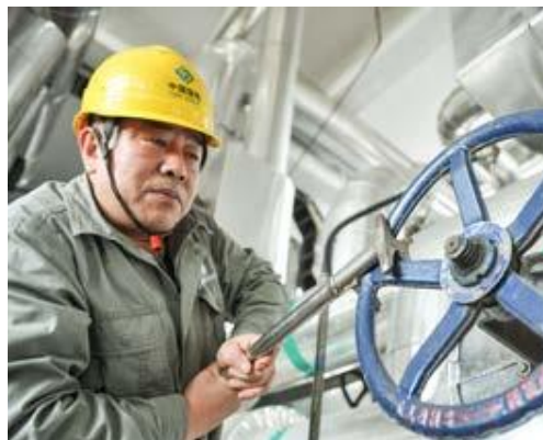
石电公司向市区开栓供暖
