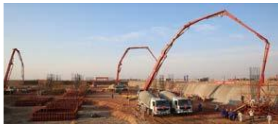
国电宁夏方家庄电厂2×100万千瓦机组工程开工
