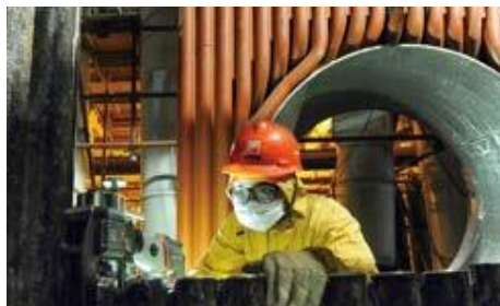
北仑公司进行提高SCR入口烟温分级省煤器改造
