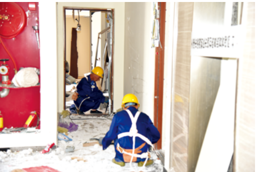
中建六局电力抢险队在救援现场施工
