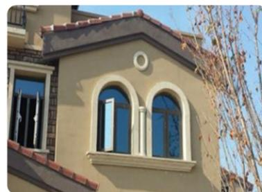
EPS构件以高强度阻燃型聚苯乙烯为基体，耐碱玻璃纤维网格布作为中间层，外层由无机抗老化聚合物乳液复合成型。产品自重轻，耐冲击，强度高，耐水性能优良，韧性好，施工时不用任何预埋件、铆固件，可以任意切割、拼接，采用特种粘结砂浆直接粘结于墙面基层即可。EPS构件能够完全替代传统的GRC构件，更适用于安装在外墙EPS、XPS保温的墙体上。既能体现欧式、古典、高雅的装饰风格，又能保证主体建筑外墙不出现冷、热桥效应。特别是在欧式风格的高层建筑以及高档别墅项目中得到了广泛应用。
