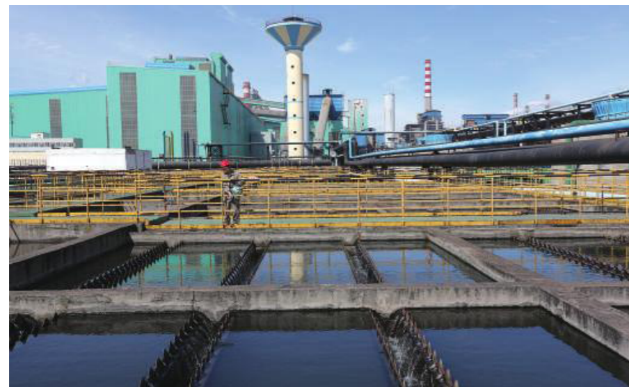
废水集中处理站
