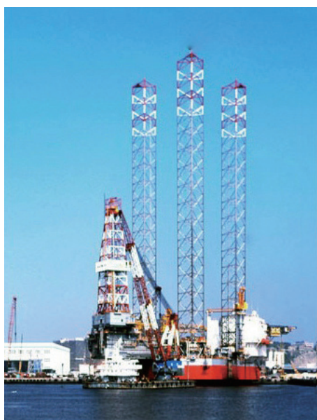
／海洋石油 942 钻井平台
