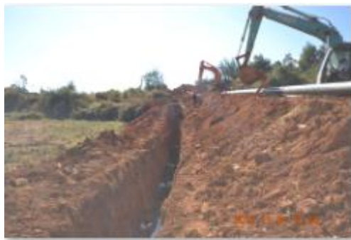
大红山管道埋设现场
