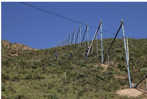
东川管道运输现场 1
