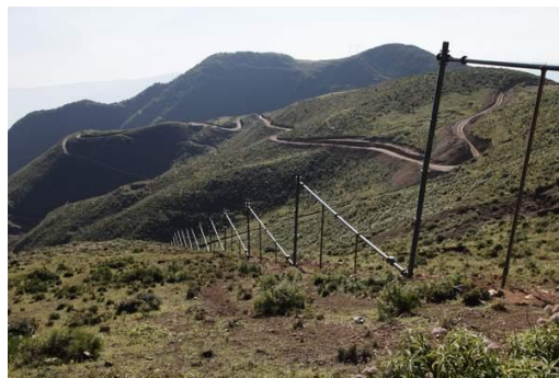
东川管道运输现场 2
