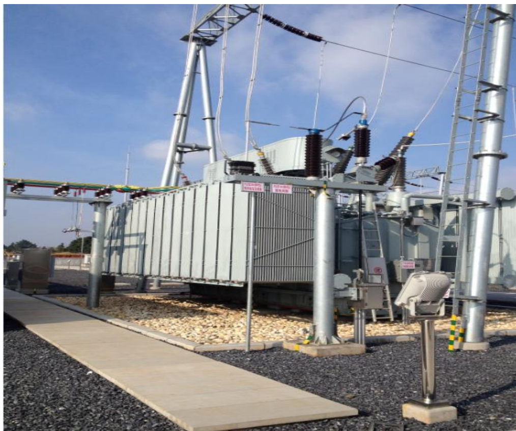
220kV 凤凰山变电站工程
