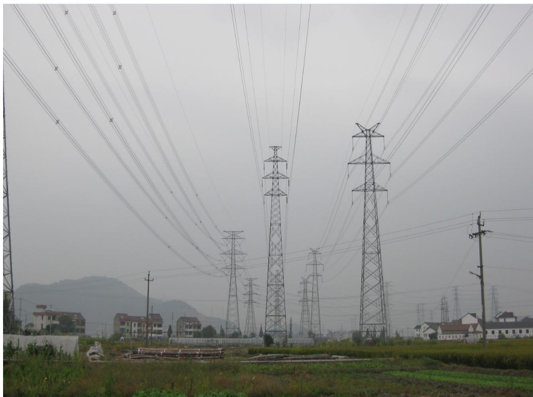
220kV 古太 4Q81(古安 4Q82 线)跨杭绍台高速升高改造工程
