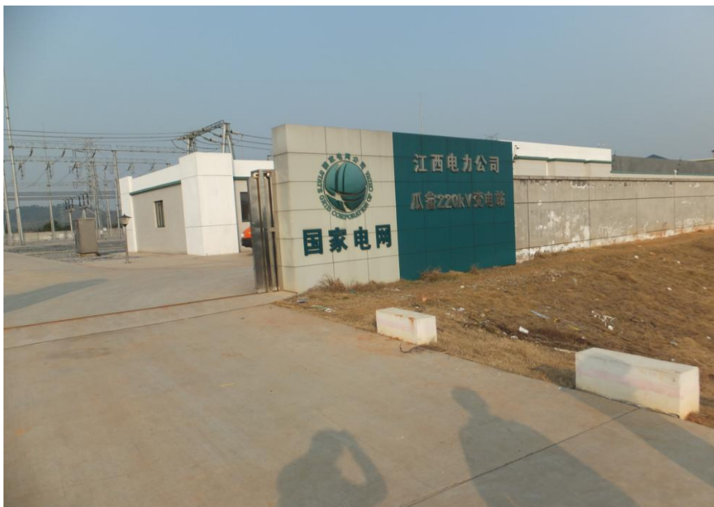
吉安-瓜畲 220kV 变电站#2 主变扩建工程
