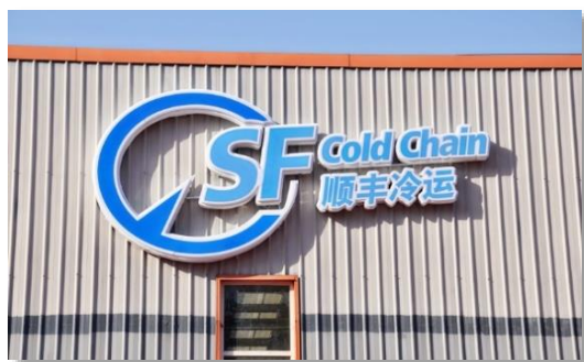
图6.36 顺丰控股冷库外观
