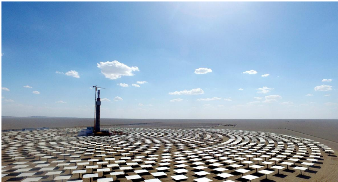
首航节能 10MW 太阳能熔盐塔式光热发电项目现场照片
