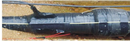
电缆接头上光纤光栅传感器应用
