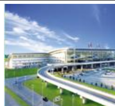
长春龙嘉国际机场航站楼
