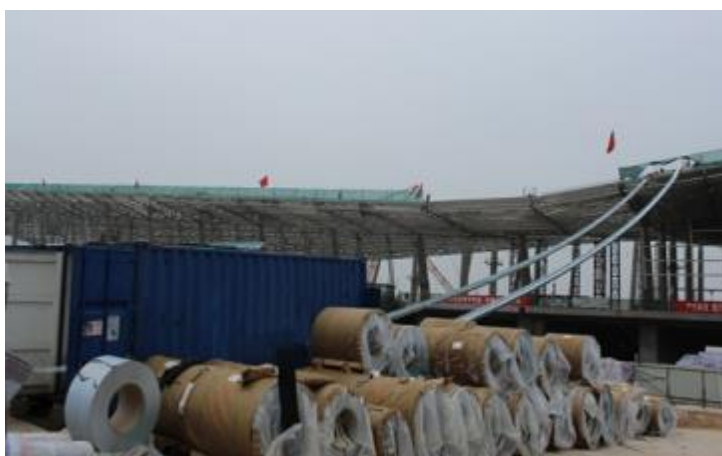
工地现场屋面板生产高空传输工艺图
