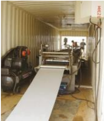
现场生产进料口
